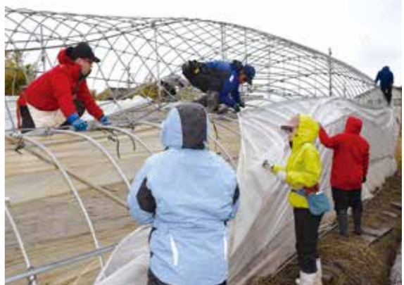
解体作業に汗を流すJA担当者
