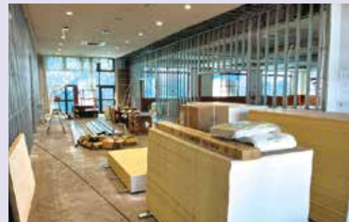
工事の様子（内観）
