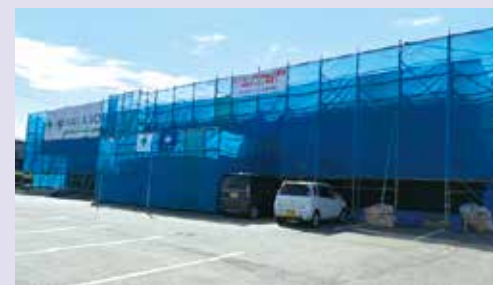
工事の様子（外観）
